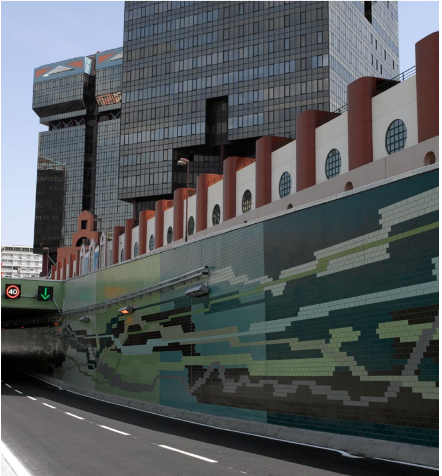
TÚNEL MARQUÊS DE POMBAL • LISBOA - PORTUGAL LISBON - PORTUGAL . LISBONNE - PORTUGAL . LISSABON - PORTUGAL
